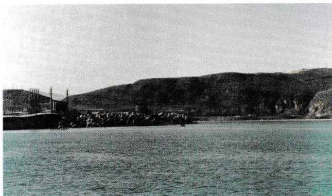
De Algerijnse kust met de zwaarbeschadigde breakwater waarbij een groot aantal van de betonnen kraaienpoten totaal verdwenen is. Tegen de breakwater ligt het voorschip van de „Maassluis”.
